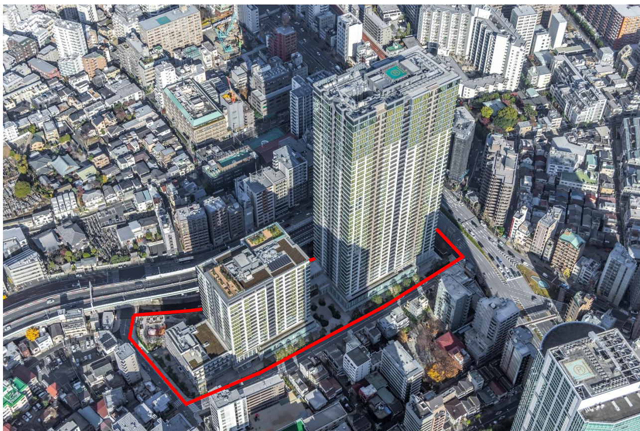
白金一丁目東部北地区第一種市街地再開発区域全景 ※赤枠内が再開発区域
