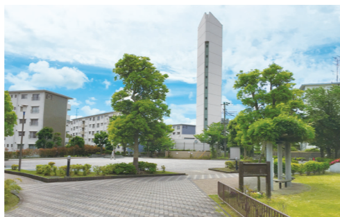
【洋光台南第一住宅の給水塔(解体前)】
