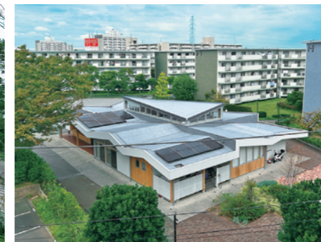
【連続折れ屋根と浮き屋根の外観】
