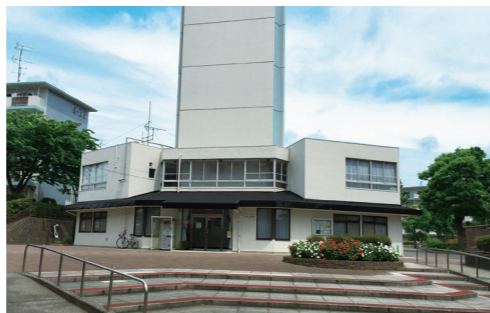
【洋光台南第一住宅の集会所・管理事務所(建替え前)】
