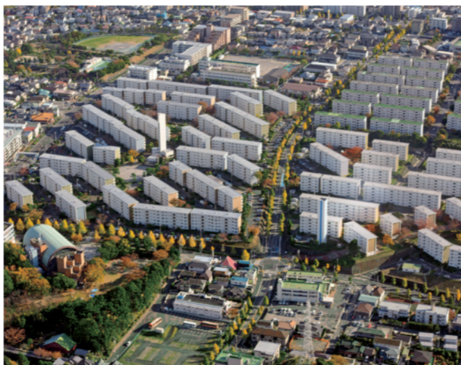
【給水塔解体前の洋光台団地】
