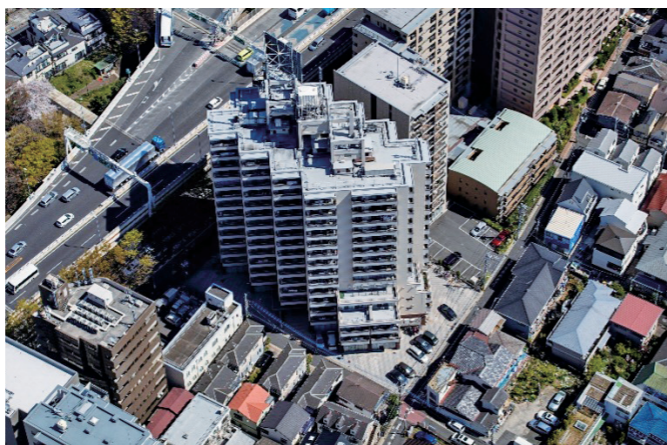
【特定緊急輸送道路に面する古河松原マンション】
