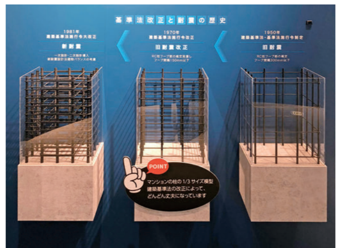
新耐震基準(左)と旧耐震基準(中・右)の柱の鉄筋の密度(長谷工マンションミュージアムの展示模型)
