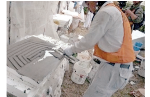
断熱材に樹脂モルタルを塗布
