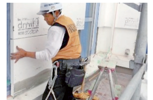
外壁に断熱材を貼り付け
