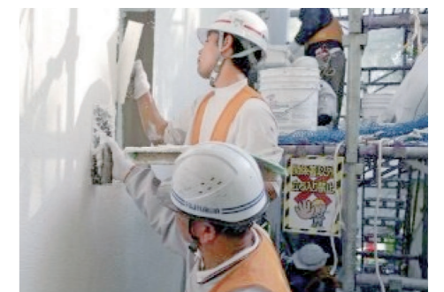
断熱材の上から鏝で仕上げる(左官仕上げ)
