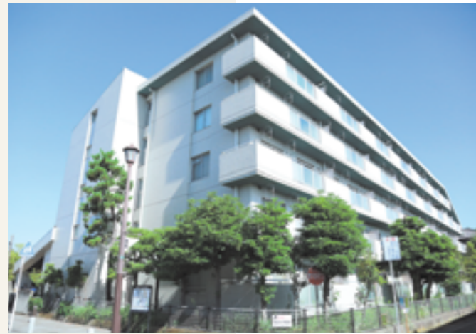
サステナプランシェ本行徳 リノベーション前
