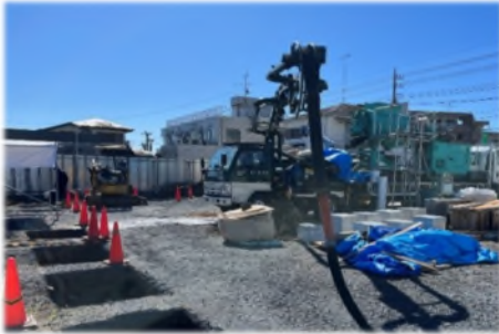
③ 左：ポンプ圧送、右：気泡混合軽量土打設
