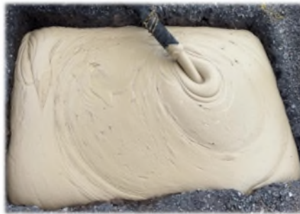
③ 左：ポンプ圧送、右：気泡混合軽量土打設
