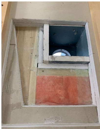
強化せっこうボードを用いた「メンブレン耐火被覆」
