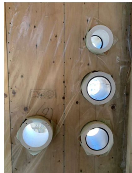
断熱スリーブを使用した省施工耐火外壁開口工法
