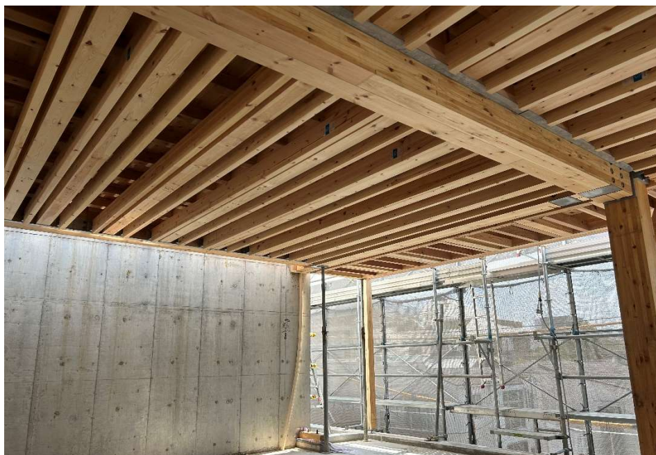
(仮称) 目黒区中央町一丁目計画 建設現場 (2024年7月撮影)
