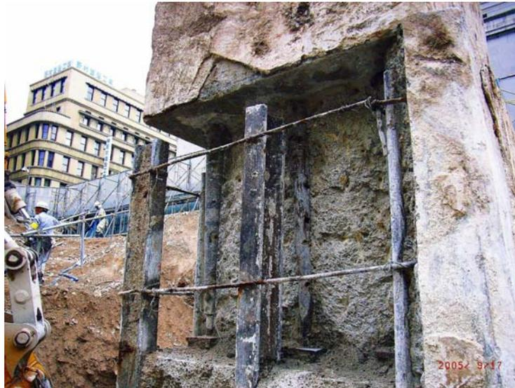
基礎柱の鉄筋として使用されている「双頭レール」
