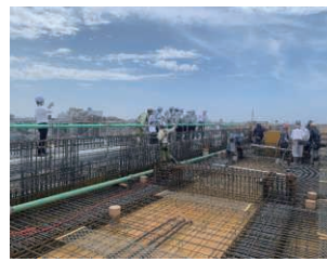
Pouring of H-BA Concrete
