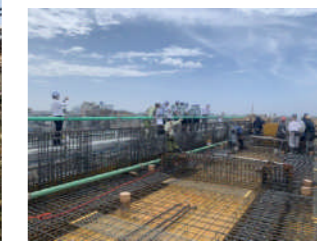
Pouring of H-BA Concrete
