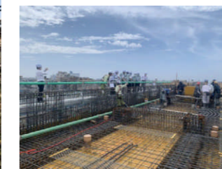
Pouring of H-BA Concrete
