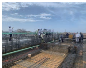
H-BAコンクリート打設の様子
