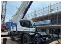
バッテリー式フル電動ラフテレーンクレーンの採用
